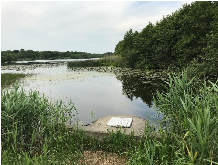
Figur 3. Bilden visar på utskovsanordningen i södra delen av sjön som reglerar vattennivån i sjön.
