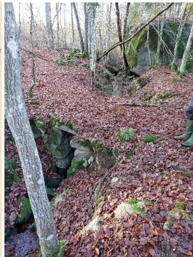
Figur 25. Stenbro över diket nedströms Agnsjön. Foto: E. Wallsten /Länsstyrelsen Blekinge
