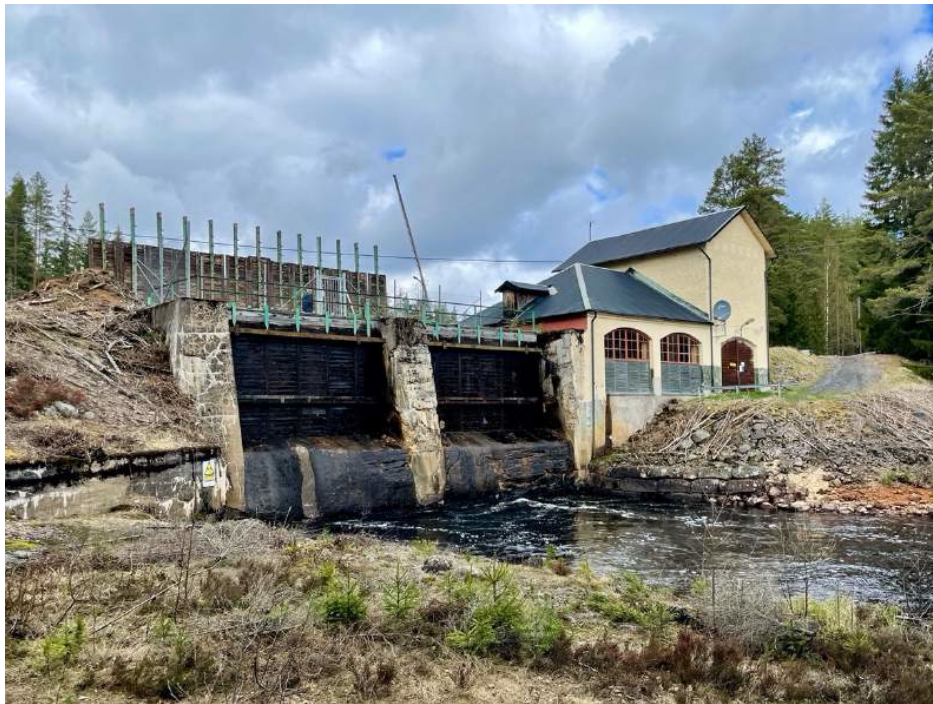
Figur 3: Älvsjöhyttans kraftverk med turbinsumpen till vänster om kraftstationsbyggnaden.
