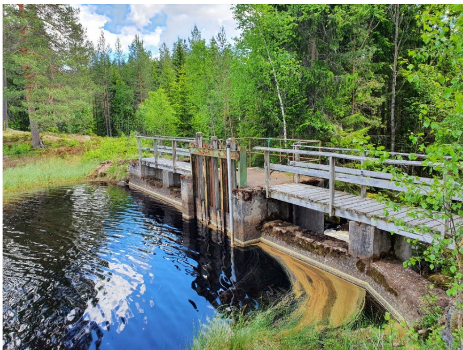
Figur 2: Regleringsdamm vid nedre Tällbergssjön
