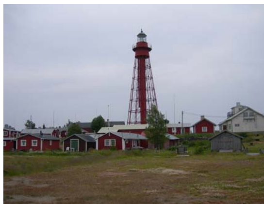
Nuvarande järnfyr uppfördes 1905. Den är ritad av fyrkonstruktör Nils Gustav von Heidenstam och stod tidigare på Sandhammar vid Skånekusten (1862).
