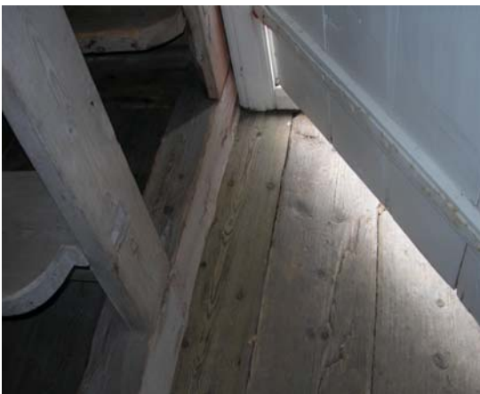
Närbilder på det såpskurade golvet och bänkgavlarnas montering i golvstock och vägg (2007).
