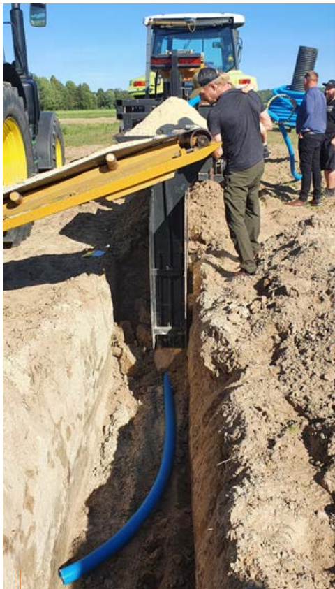
En dikesplog som både gör kanal, lägger ned slang och lägger på täckmaterial.
